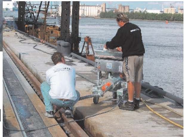
Cotainer Terminal Hamburg Altenwerder
