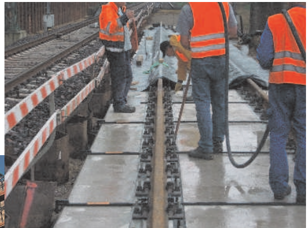
Deutsche Bahn ICE Feste Fahrbahn
